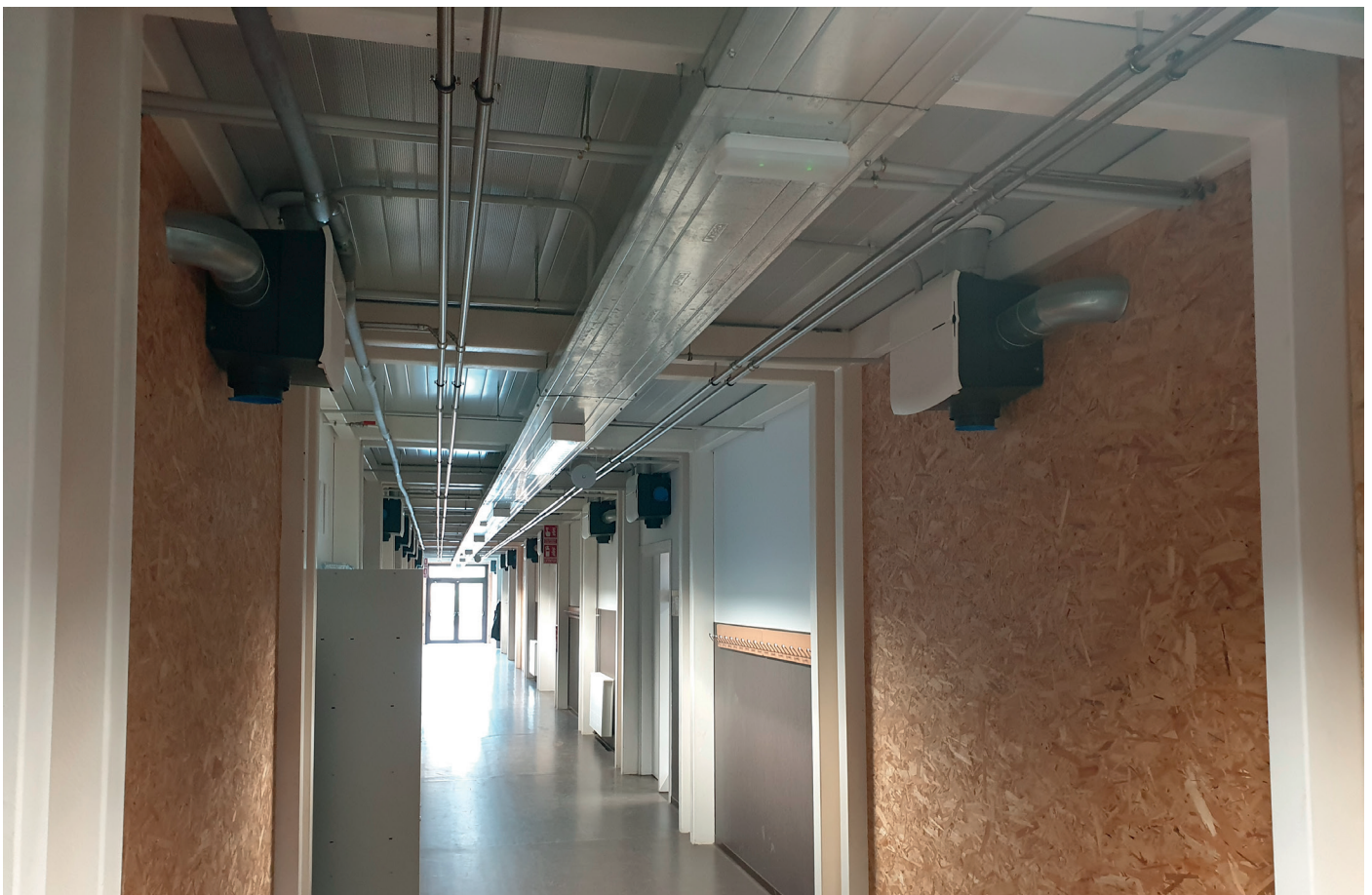
Ejemplo de sistema de extracción descentralizada en pasillos con equipos MVS-15P.
